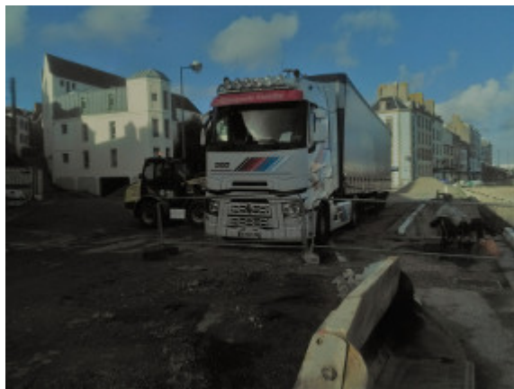
Travaux au Port du Rosmeur, Douarnenez, novembre 2018 © DR
